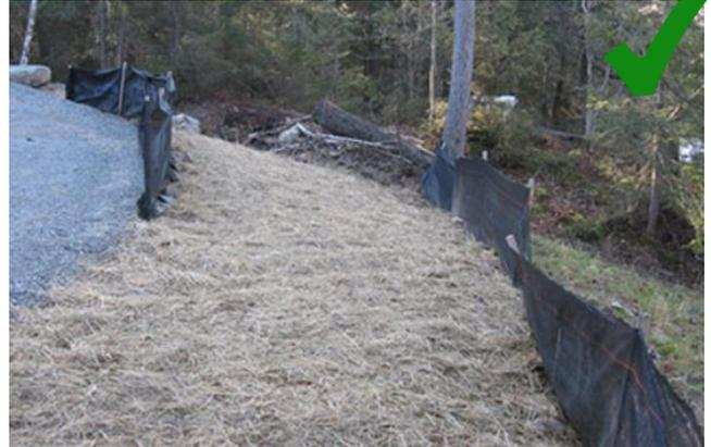
La barrière a été doublée et une stabilisation temporaire (paillis de paille) recouvre les surfaces remaniées sur le site des travaux. La combinaison des méthodes diminue grandement les risques d'érosion.
