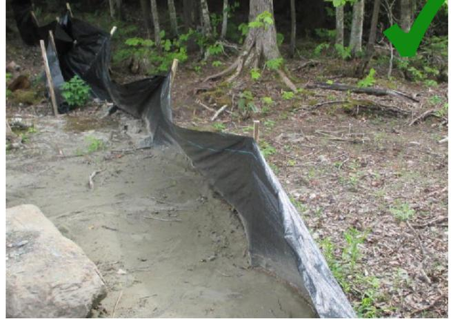
La barrière est installée sur un terrain plat, où il n'y a pas de fort débit d'eau. Elle est bien enfoncée dans le sol et permet efficacement de confiner les sédiments sur le site des travaux. La végétation à l'extérieur du site des travaux ne sera donc pas perturbée.
