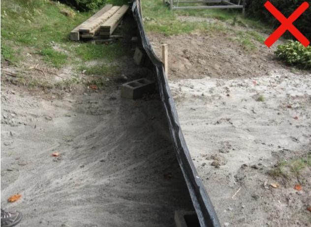
La barrière n'a pas été enfoncée dans le sol à l'endroit où l'eau de ruissellement circule préférentiellement. Les sédiments migrent et s'accumulent à l'extérieur de la zone des travaux, causant des dommages au milieu environnant (étouffement de la végétation, envasement du lac, etc.).
