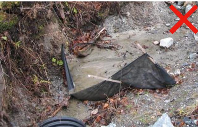
La barrière est utilisée dans un fossé possédant un fort débit de ruissellement. L'eau force sur la barrière et utilise les côtés du fossé pour contourner l'obstacle : ce type d'installation cause des problèmes supplémentaires d'érosion plutôt que de les prévenir.
