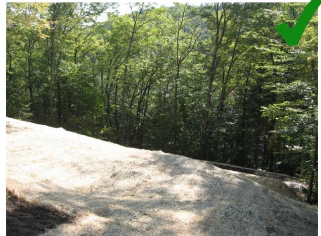
Les matelas anti-érosion ont été installés dans une zone de construction en forte pente et ils recouvrent la totalité des sols mis à nu.
