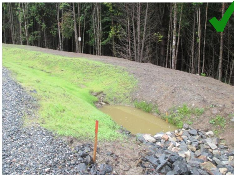
En période de faible débit, l'eau s'accumule derrière le seuil de rétention, permettant la décantation des sédiments. En période de fort débit, le système de trop plein combiné à l'élargissement du fossé, créé par l'aménagement de la trappe, ralentira l'écoulement de l'eau pour permettre une certaine décantation des sédiments.
