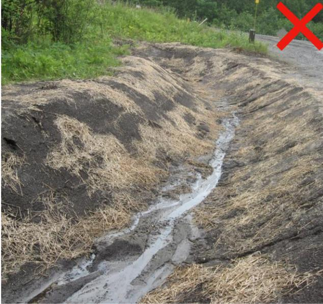
Le recouvrement des talus de fossé par du simple paillis de paille n'est pas efficace. Dès la première pluie, le paillis risque d'être destabilisé et emporté par le ruissellement.
