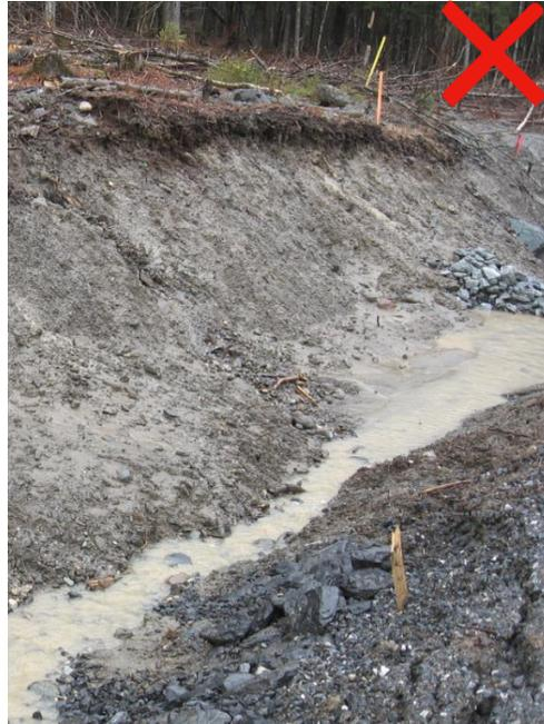
Le talus des fossés d'une nouvelle rue n'a pas été stabilisé immédiatement après les travaux. Du matériel se détache des talus et est transporté par l'eau de ruissellement.
