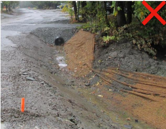
Le matelas anti-érosion a été installé parallèlement au sens de la pente, ce qui a créé un affaissement dans le haut du talus. De plus, le matelas a été installé uniquement d'un côté du fossé.
