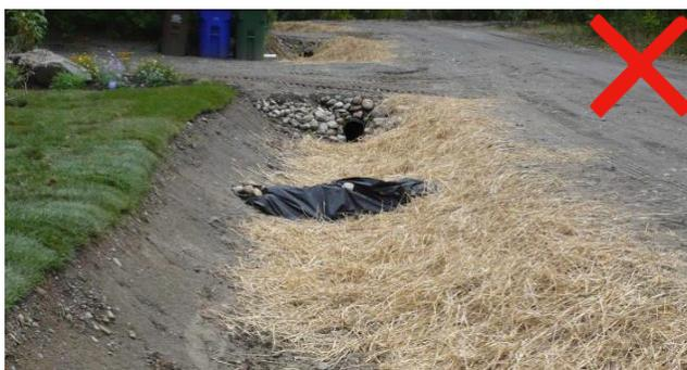
La berme de rétention doit couvrir la largeur du fossé, afin d'éviter que l'eau ne la contourne. Il n'est pas recommandé qu'elle soit recouverte d'un géotextile lorsque nous sommes en présence d'un fort débit, vu qu'elle devient plus hermétique à la circulation de l'eau.
