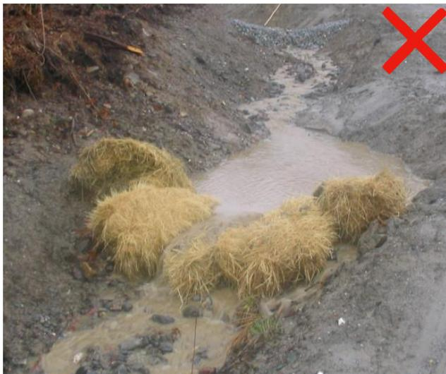
L'utilisation des ballots de paille pour servir de bermes filtrantes dans les fossés a été largement utilisée dans le passé, mais n'est pas recommandée. Dans la grande majorité des cas, ils causent plus de problèmes (dû à une mauvaise installation) qu'ils n'en règlent, puisque l'eau de ruissellement est portée à les contourner.
