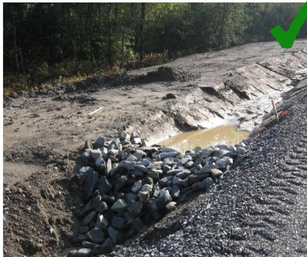
La berme de rétention est bien installée, avec une physionomie qui permet de résister à la poussée des eaux de ruissellement provenant de l'amont. L'eau s'accumule devant la berme, permettant la décantation d'une partie des sédiments avant l'arrivée au cours d'eau. Seul point à améliorer dans cette photo : les talus du fossé ainsi que les sols à nu sur le pourtour devraient être stabilisés immédiatement.
