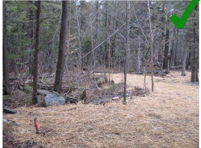
Le paillis est utilisé sur une surface plane, sur l'ensemble du sol mis à nu. Le sol est ainsi protégé de l'effet érosif des gouttes de pluie, en plus de diminuer l'impact visuel des sols mis à nu et de créer un microclimat propice à la germination des graines, une fois que le sol sera semé.
